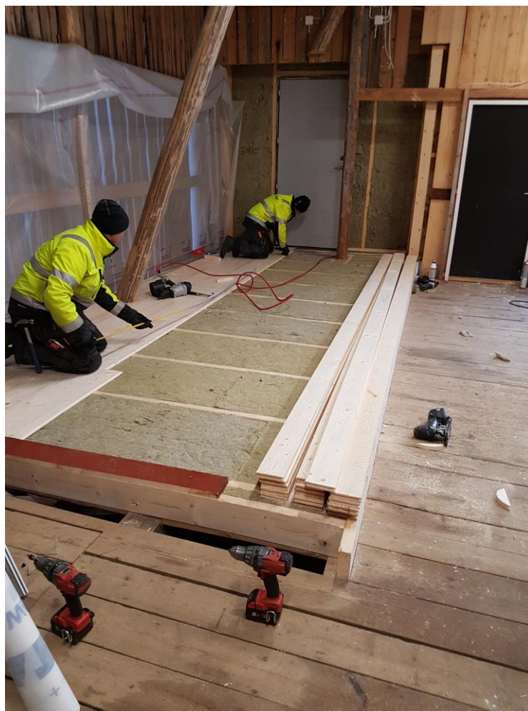
Byggprojekt i Nordsjö.
