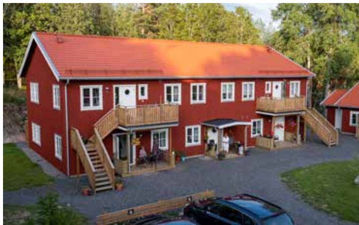
Nybyggt hyreshus i Stavsjö Foto Rocco Gustavsson
