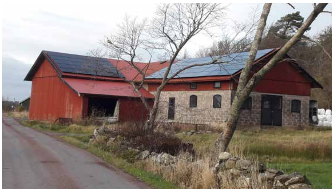
Solceller på ladugårdstak, ger sommartid el-överskott som säljs in på el-nätet. Bremnäs, Lycke Foto Gunilla Almered Olsson
