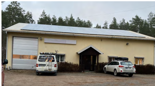
Företaget Äventyrsservice tak rymmer en stor anläggning. Foto: Lena Husén
