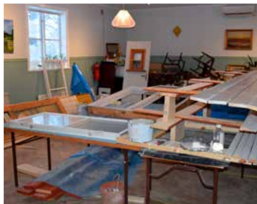
Bygdegården har genomgått en omfattande renovering. I juni blir det invigningsfest.
