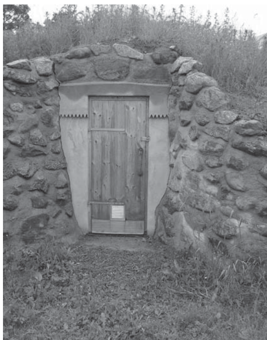
Matkällare i Växhusets Ekocentrum, Mobodarne, Söderhamn. Foto: Jan Forsmark
